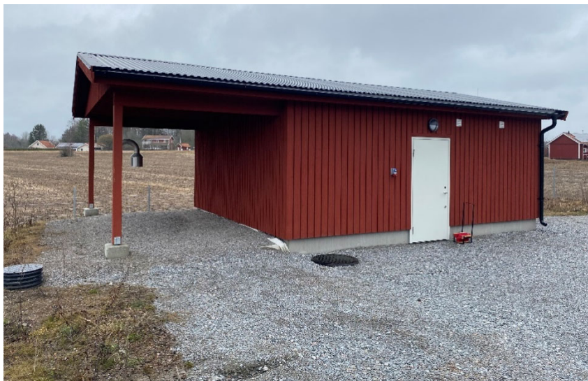
Figur 4. Ny tryckstegringsstation inkl. reservoar i Länna.
